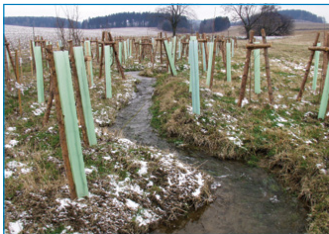
Obr. 3, 4, 5, 6. Obnova (1999–2000) dvou dříve zatrubněných toků v polích, Dolní Moravice, severní Morava. Po vyjmutí betonových trubek a utěsnění vzniklé rýhy bylo bagry vytvořeno povrchové mělké a členité koryto a vybudováno několik retenčních nádrží. Celý široký prostor mezi rybníčky byl následně osázen autochtonními dřevinami v rámci realizace lokálních biokoridorů. (L. Bureš)
