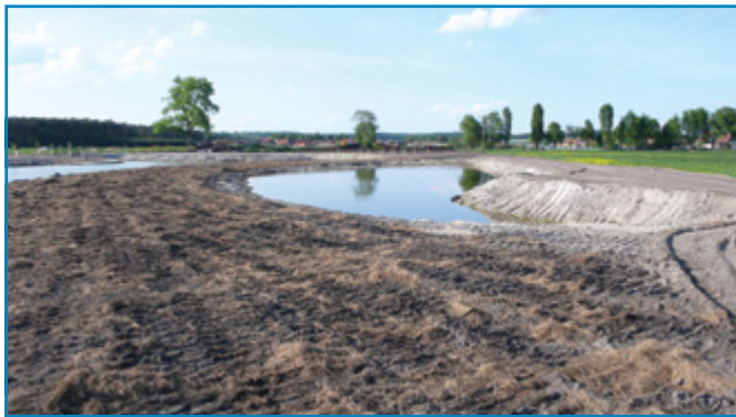
Obr. 11, 12. Tvorba tůní a mokřadů s výsadbou dřevin na 5,6 ha v lokalitě Hladoměř, střední Čechy. Vlevo: tůň na jaře 2011; sušší části jsou pokryty zeleným senem. Vpravo: vegetace v létě 2011. (T. Just)
