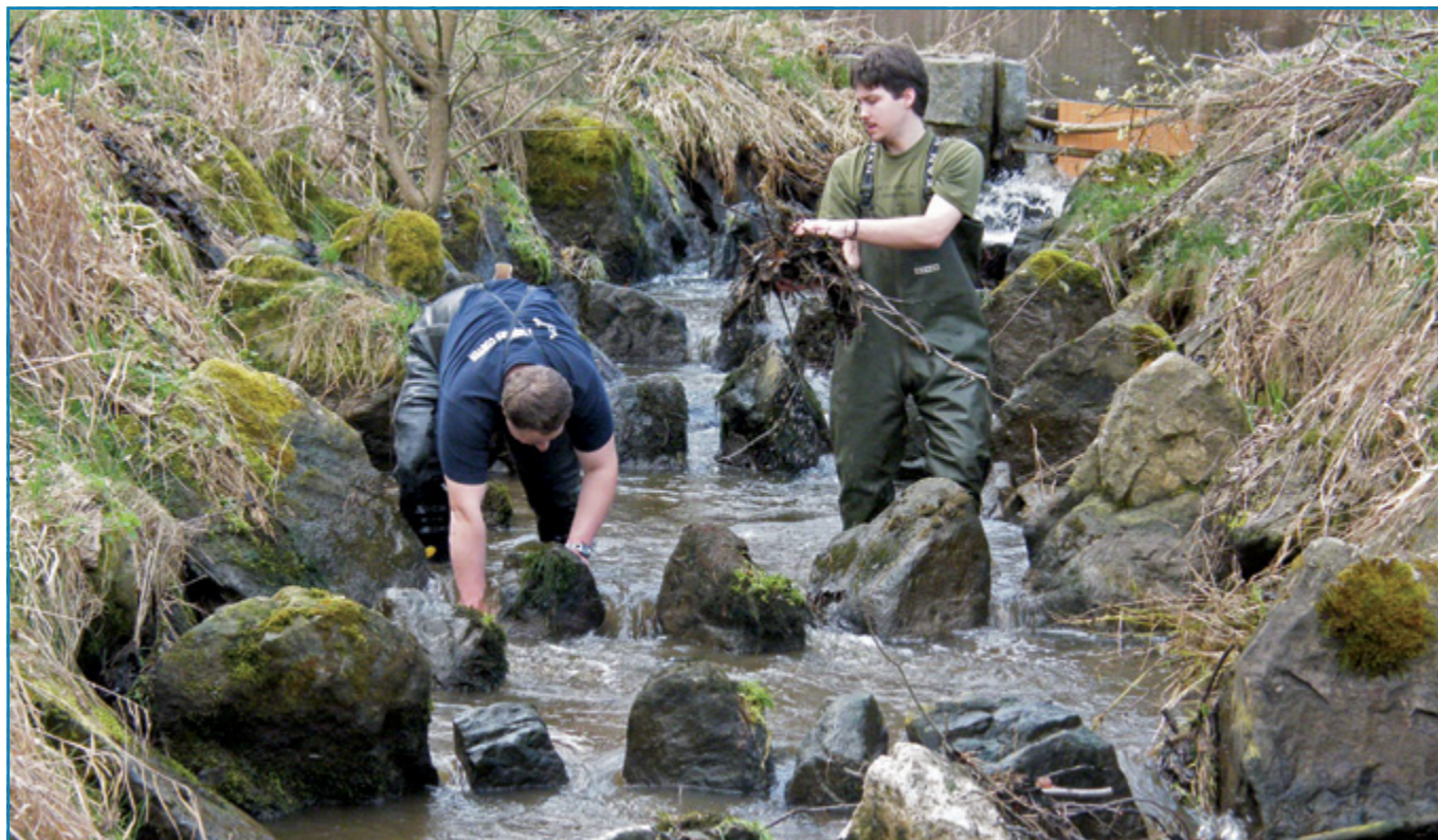
Obr. 4. Odstraňování naplavenin z bypassu při sníženém průtoku. (P. Dvořák)
