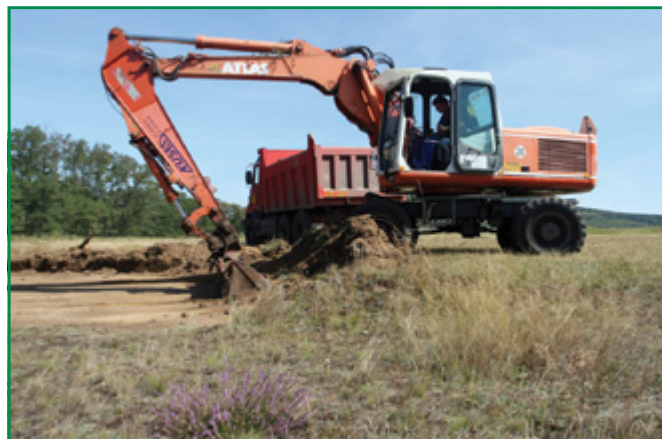
Obr. 4. Stržení humusové vrstvy v roce 2009. (J. Bělohoubek)
